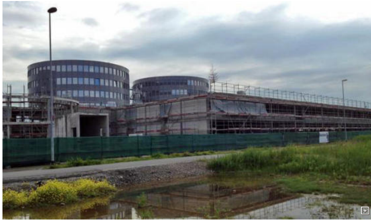
Der sich im Bau befindende Hotelkomplex, dahinter die «4-Towers». (PD)
