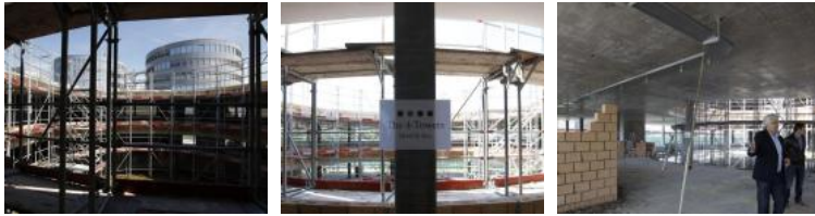
In Steinhausen schreiten die Bauarbeiten auf dem Areal der 4-Towers zügig voran. Unter anderem entsteht das grösste Fitnesscenter der Zentralschweiz. Ab Juni beginnt der Innenausbau.
